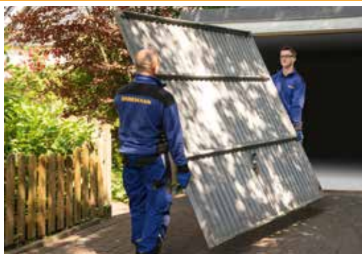
Ausbau und umweltgerechte Entsorgung
